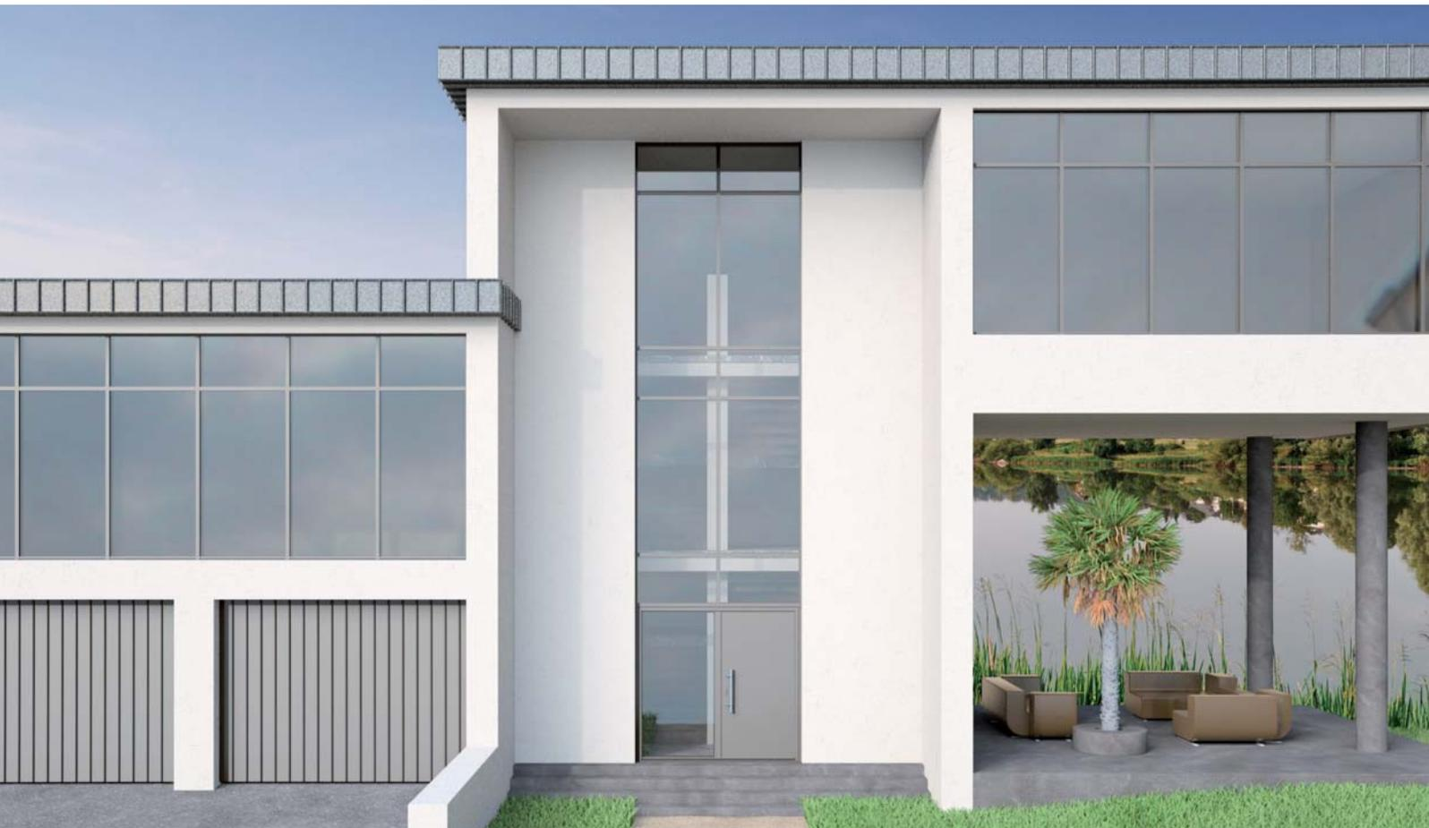
La cage d'escalier vitrée est toute particulière : la façade vitrée généralement étroite, repose au dessus des traverses, sans mise en œuvre nécessaire de poteaux.
