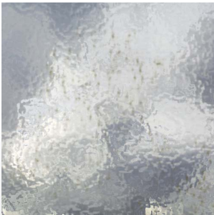
4. La pluie forme un film uniforme sur le vitrage.
