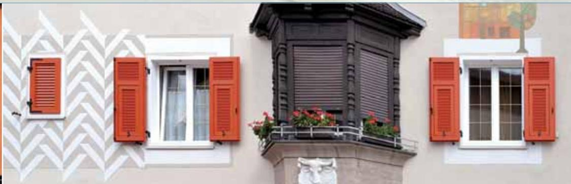
*Classic-line. Les profils élancés aux angles arrondis et atténués confèrent une esthétique proportionnée et un aspect d'ensemble attrayant. Multichambre avec renforts acier et vitrages isolants, l'ensemble fait preuve de bonnes valeurs d'isolation thermo-acoustique, de solidité et fonctionnalité.*
